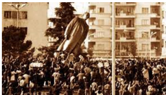
Fig. 1. Demolarea statuii lui Enver Hoxha, Tirana, februarie 1991.
